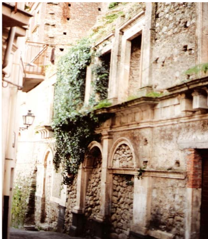
Foto n° 2 - Via Abate Coniglio
