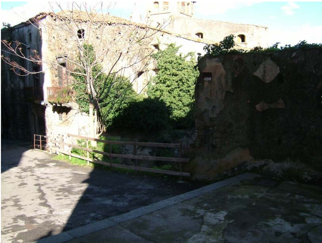
Foto n° 8 – Via IV Novembre
