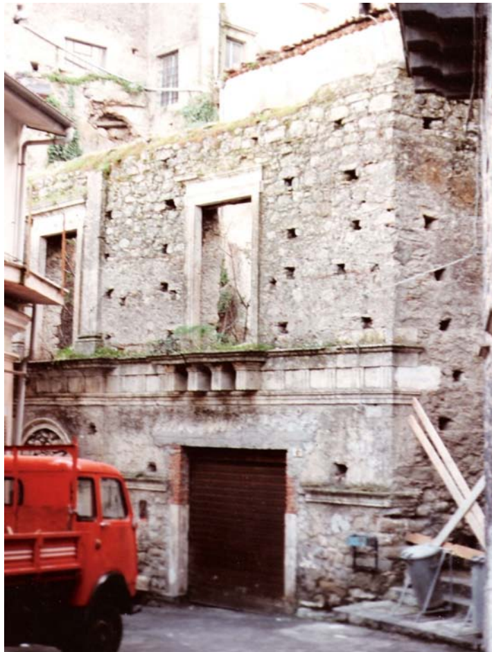
Foto n° 4 - Via Abate Coniglio
