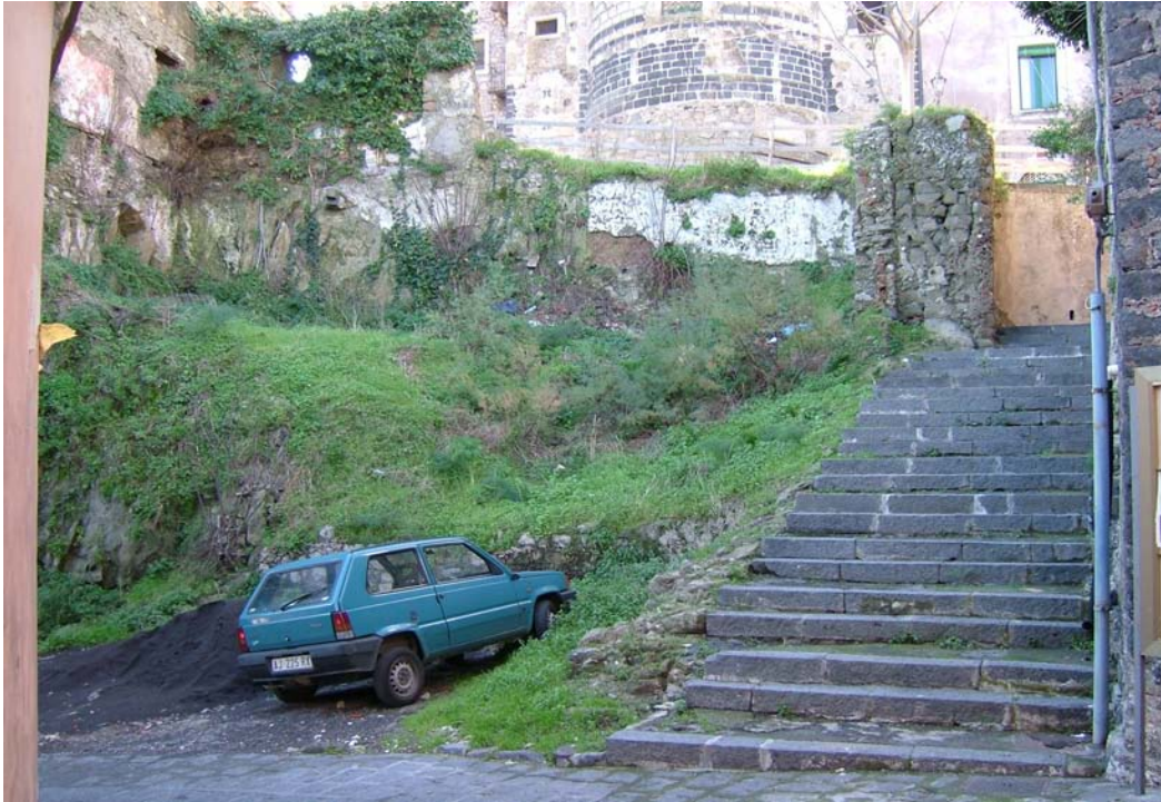
Foto n° 5 - Via Abate Coniglio
