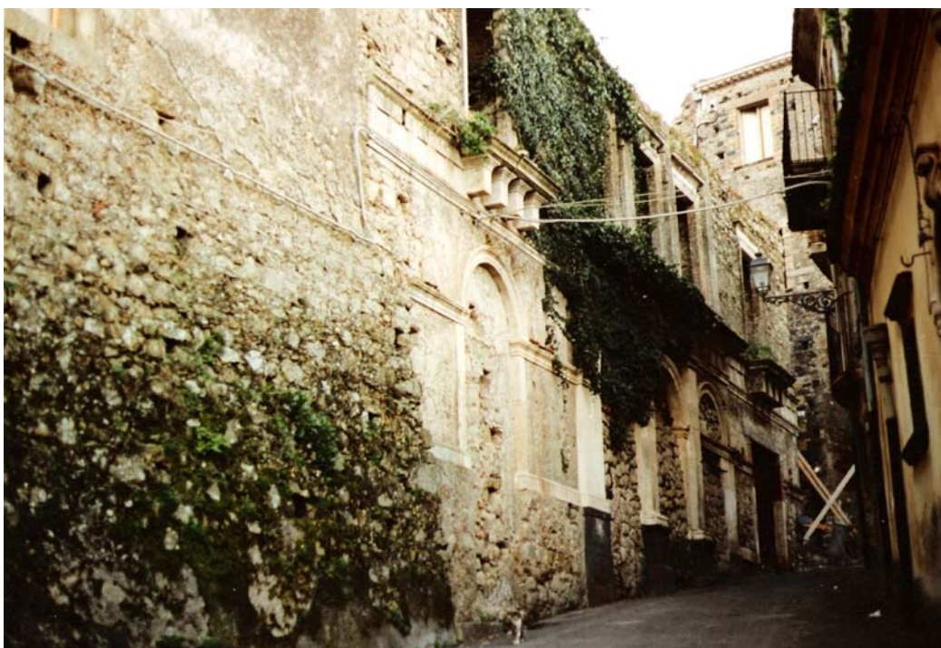
Foto n° 1 - Via Abate Coniglio
