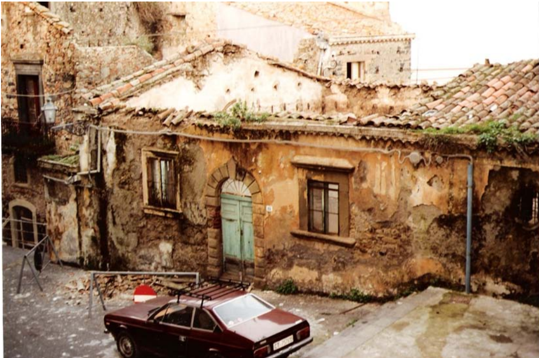
Foto n° 3 – Via IV Novembre
