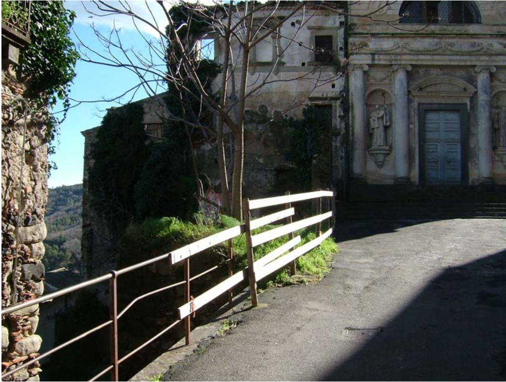
Foto n° 7 – Via IV Novembre
